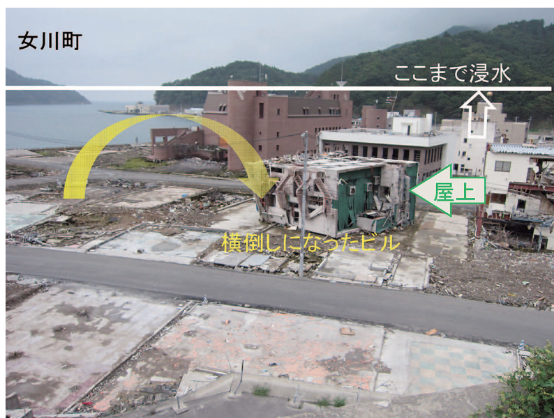
図4 女川中心部、高い波と横転したビル
