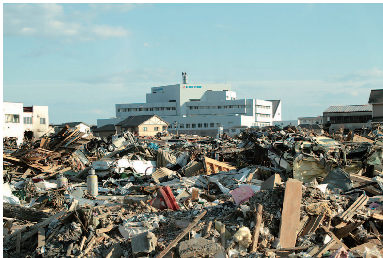
図6 瓦礫にかこまれた石巻市立病院
