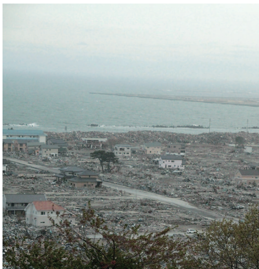
図5 日和山より眼下の壊滅した市街地をのぞむ
