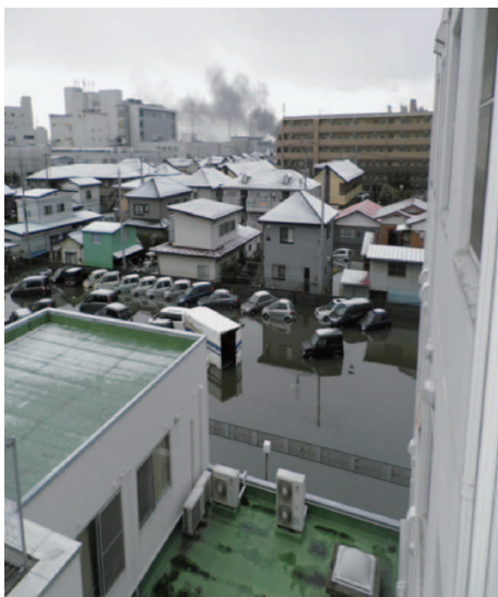
病院側面 (南側。駐車場の車は水没し、流れ着いたコンテナがみえる)
